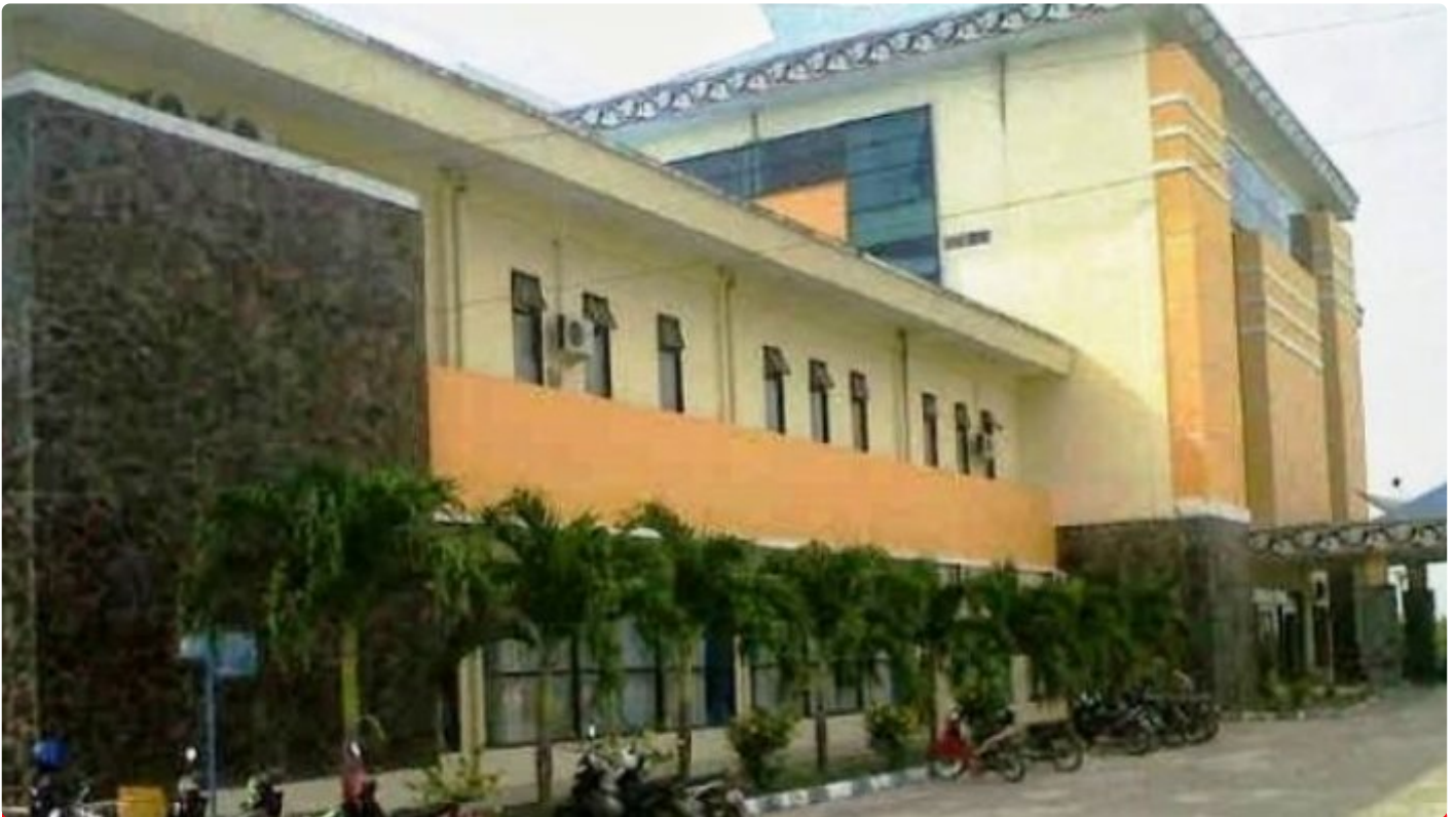
Keterangan Photo : RSUD Perdagangan
